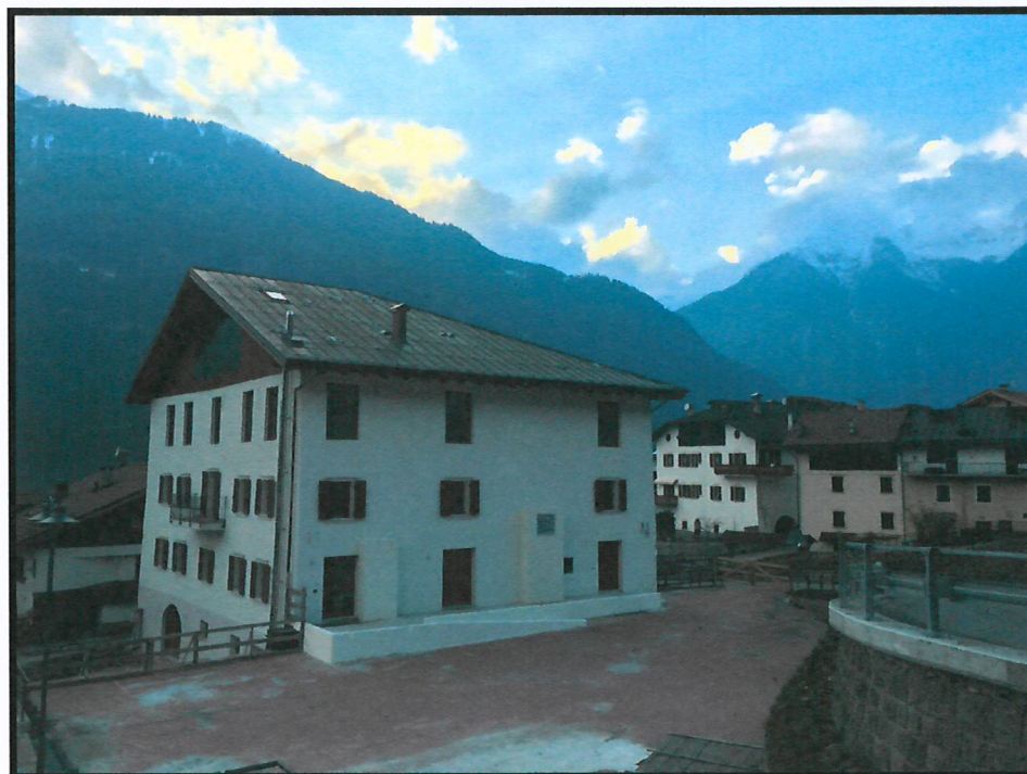
- Vista generale sud/est -
