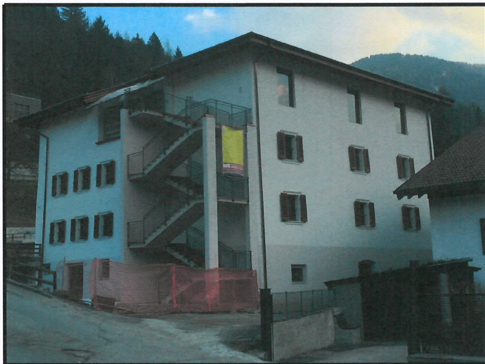
- Vista generale nord/ovest -
